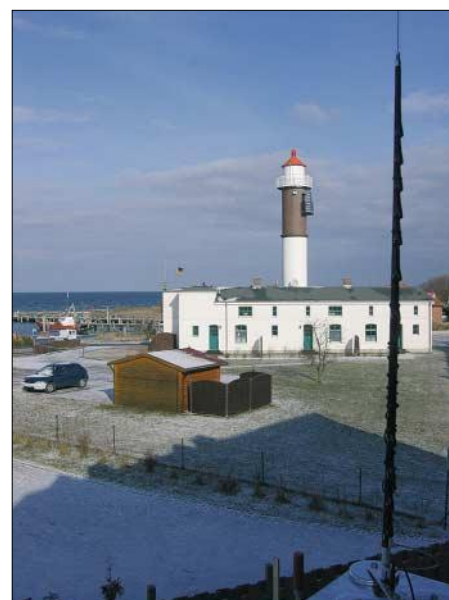
Blick zum Leuchtturm Timmendorf, im Vordergrund die Outbacker-Antenne
